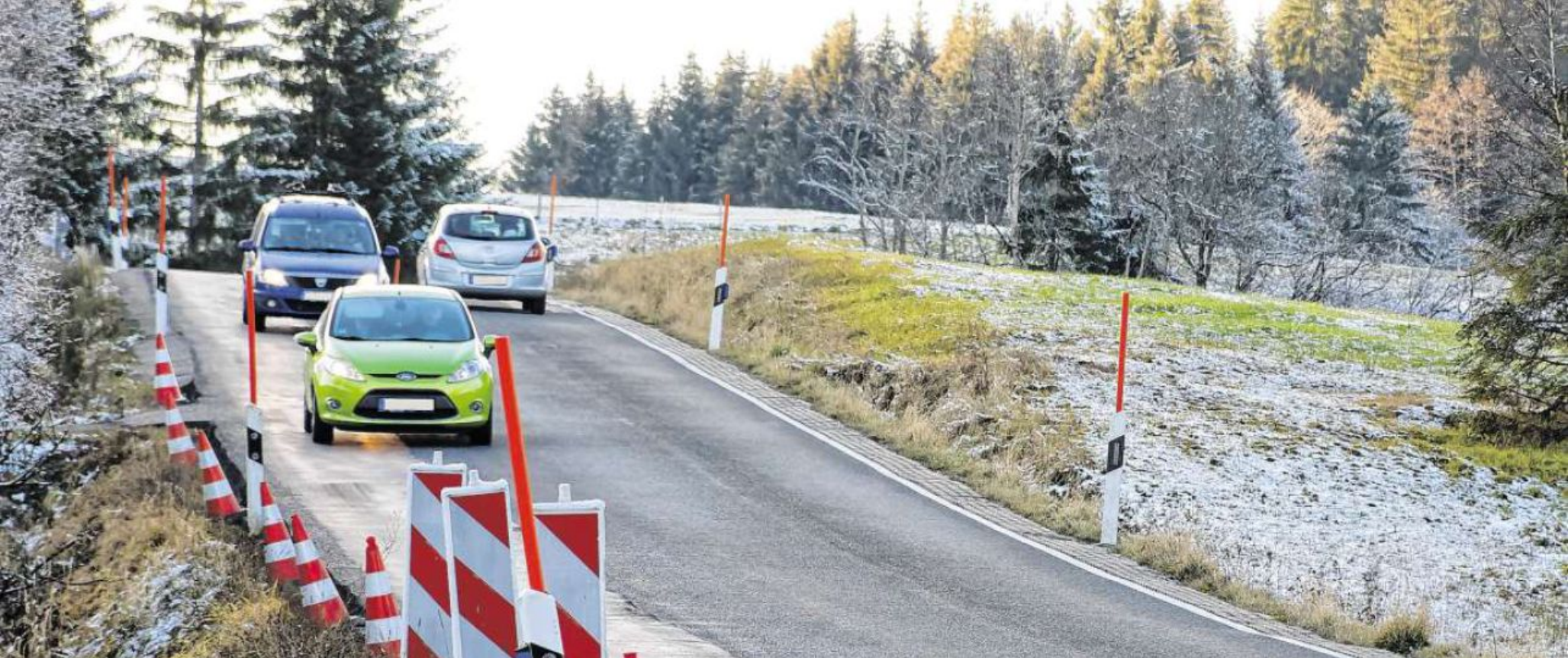
Immer wieder werden Teil-Abschnitte der Staatsstraße zwischen Wertach und Kranzegg saniert. Teilweise sinkt dort der Straßenrand wegen des Untergrunds ab. Aber ein Neubau der Straße wurde nur auf einem Teilstück von Wertach bis Kranzegg vor einigen Jahren verwirklicht. Der größte Teil der Verbindung ist wellig und schmal. Für Radfahrer ist es dort extrem gefährlich, ist immer wieder zu hören. Archivfoto: G. Jansen
