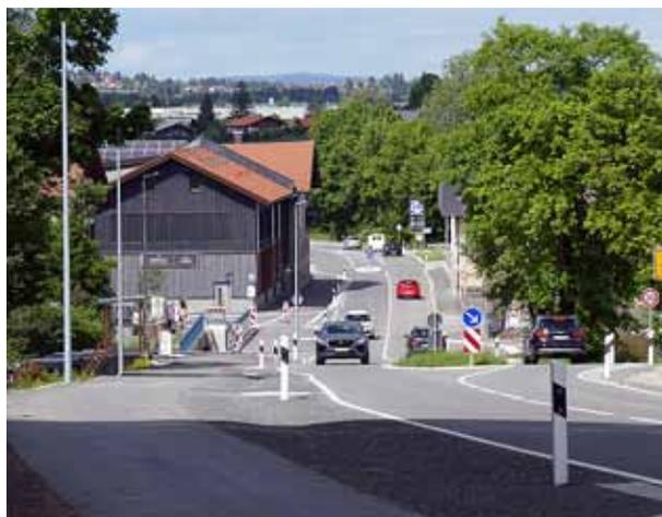
Die Engstelle am Gasthof Krone wurde verbreitert, die Unterführung saniert und weiter nördlich eine Querungshilfe errichtet.
